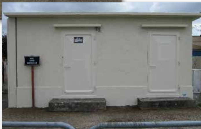
Commune de Château-Landon - Poste Carnot
